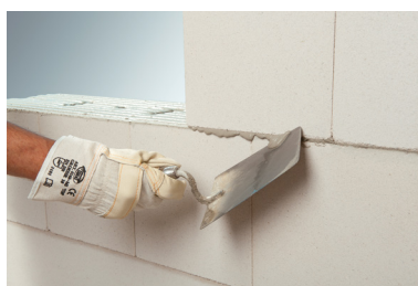
Odstranění přebytků malty hranou lžíce po jejím zavadnutí
