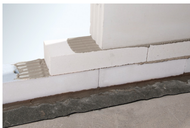
Založení první řady pomocnou tvárnici Ytong Start
