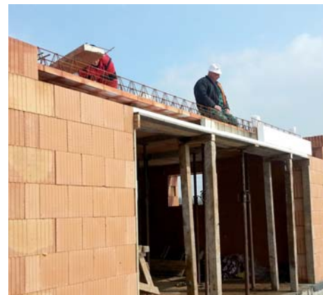
Překlady Porotherm KP XL umožňují snadnou montáž nad otvory až do 6 m.
