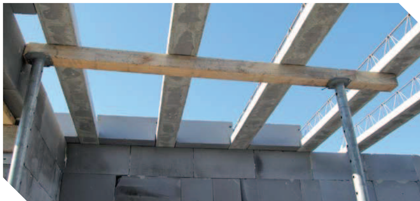
Podepření stropních nosníků
