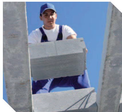
Ukládání stropních vložek
