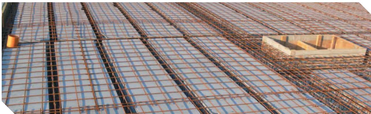
Vyskládaný a vyarmovaný strop před betonáží
